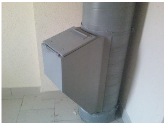
Рисунок 3. Фото загрузочного клапана в составе мусоропровода 22-х этажного здания в г. Люберцы, ул. Кирова, дом 9, корп. 3
