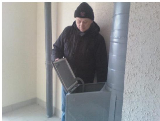
Рисунок 3. Фото загрузочного клапана в составе мусоропровода 22-х этажного здания в г. Люберцы, ул. Кирова, дом 9, корп. 3
